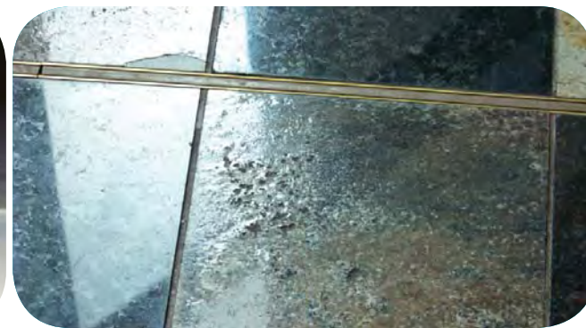
SPALLING
